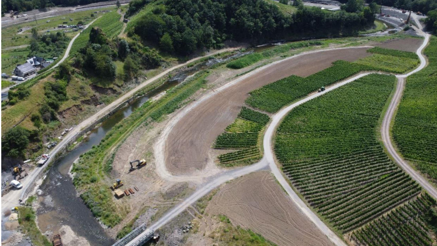
Gewässeraufweitung / Schaffung von Überflutungsflächen in Mayschoss-Laach, Quelle: Kreisverwaltung Ahrweiler
