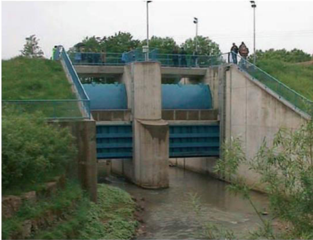
Abb. 4.22: HRB Waibstadt-Bernau, HWEA im Durchlassbauwerk mit Fischbauklappe, Neckarbischofsheim
