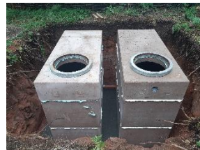
Zisternen und Erdkeller aus Ziegelsplittbeton
