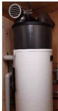
Warmwasser- Wärmepumpe
