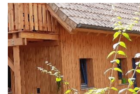
Dachüberhang schützt die Fassade
