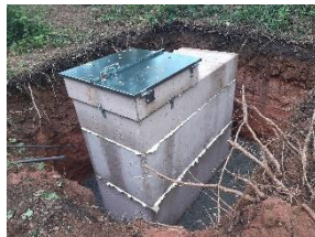
Zisternen und Erdkeller aus Ziegelsplittbeton
