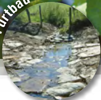
An Stellen wie diesen sind Furten statt Betonrohre die bessere Lösung. Die meisten im Bach lebenden Tiere (nicht nur die Fische) müssen jährliche Laich- und Nahrungswanderungen durchführen, um langfristig in einem Gewässersystem überleben zu können.
