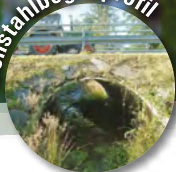
Wo zuvor Betonrohre für viele im Bach lebende Tiere unüberwindbare Barrieren waren, wurden passierbare Möglichkeiten geschaffen.
