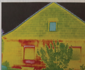
Im Wärmebild lässt sich erkennen, dass über Fensterbänke der linken Haushälfte viel Wärme langt (im Bild rot getarbt).
