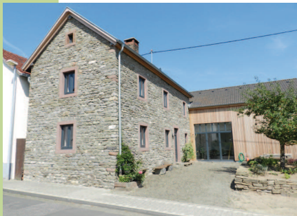
Hofanlage nach dem Umbau
