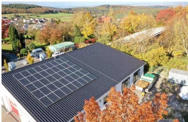
Abbildung 13: Mehrzweckgebäude Ramersbach mit Photovoltaik-Anlage
