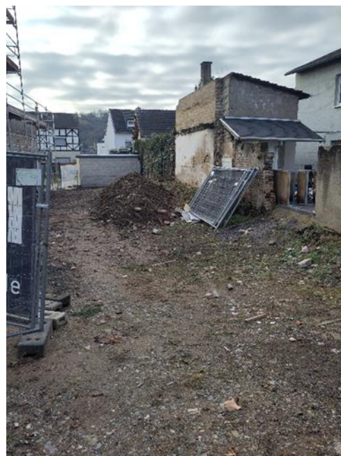
Abbildung 31: Bau des PikoParks Sinzig
